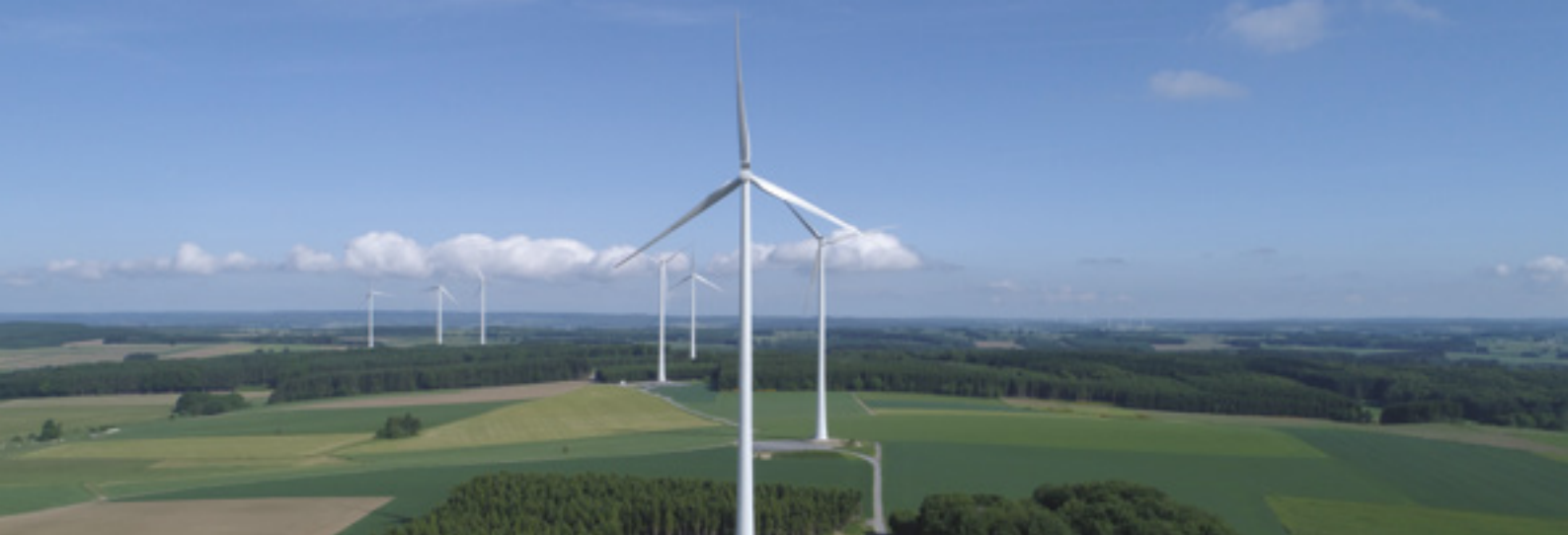
/ Parque eólico - Wincrange /
