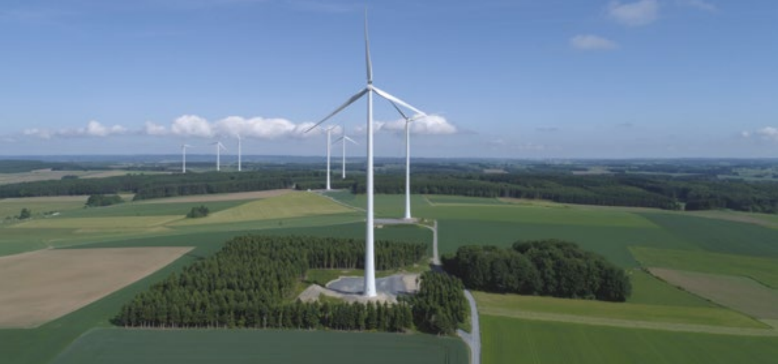
/ Parque eólico – Winccrange /
