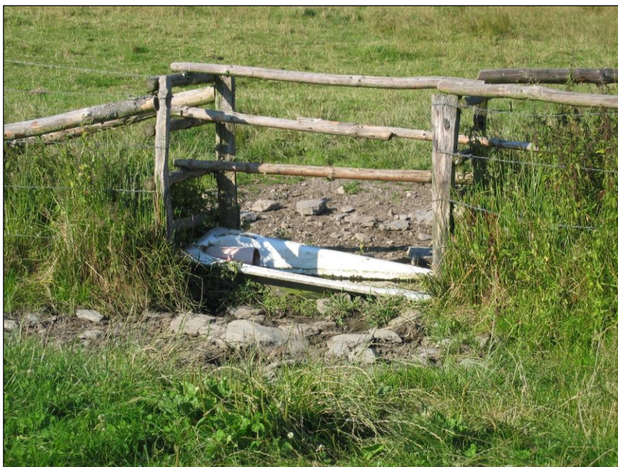
Foto 45: Der obere Bereich des namenlosen Seitenbaches B39 wurde begradigt, teilweise verrohrt und hier als Viehtränke verbaut.
