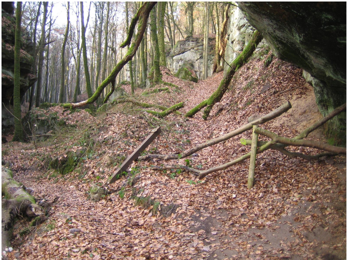
Photo 50: Les chemins de la RFI doivent être régulièrement nettoyés et dégagés ©EFOR
