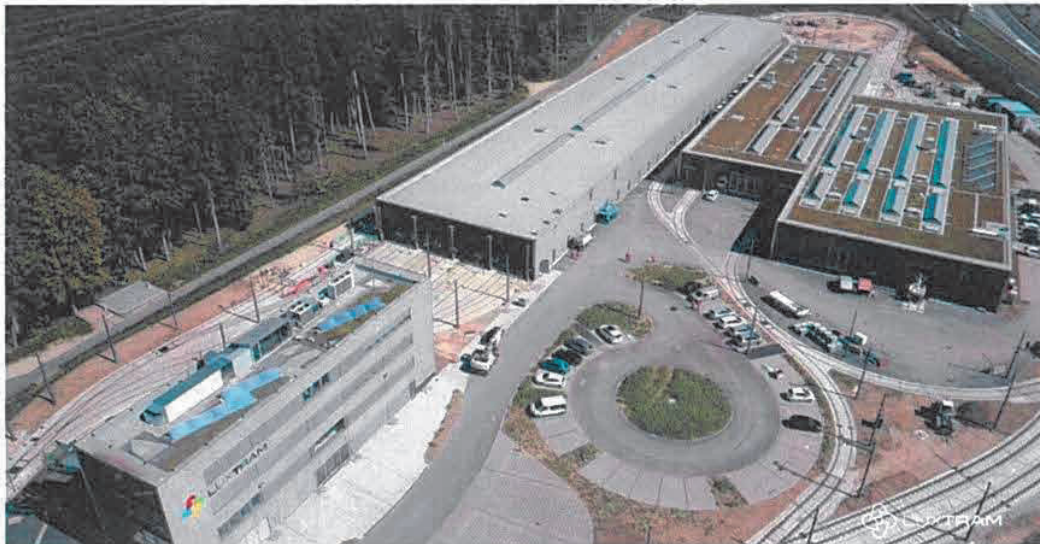
Le Centre de Remisage et de maintenance de Luxembourg
