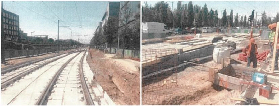
Travaux de plateforme du tram et des quais sur l'avenue Kennedy
