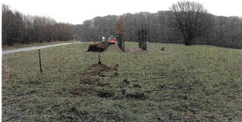
Mesure de reboisement liée à la construction du CRM (décembre 2014)
