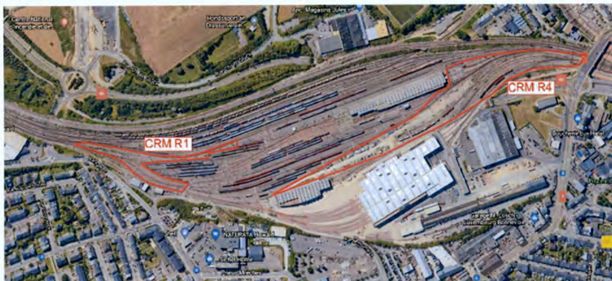
Figure 8: Centre de Remisage et de Maintenance avant le début de la deuxième phase des travaux
