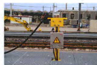
Figure 3: Bornes de préchauffage
