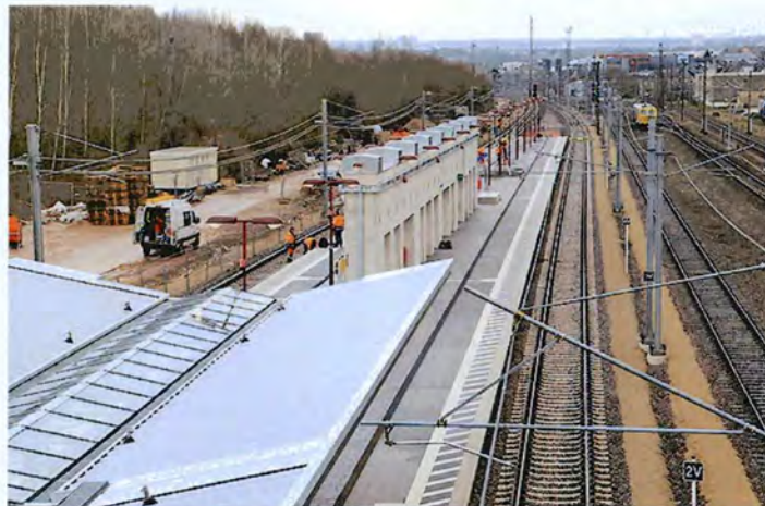
Piliers de la future plateforme d'échange
