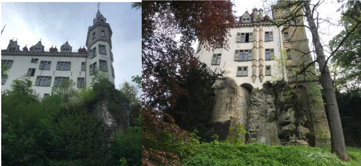
Abbildung 10: Fläche 5 umgrenzt einen natürlichen Fels, auf dem das Schloss errichtet worden ist.
