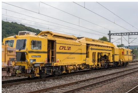
Bourreuse CFL : machine pour le réglage de la voie ferrée
