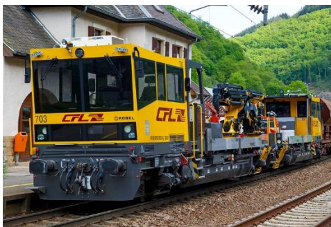
Robel CFL : l'engin multifonctions (grutage, soudure des voies, plateforme de travail pour les caténaristes)
