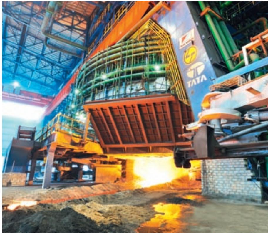
Construction du nouveau haut fourneau «H» de Tata Steel en Inde (plancher de coulée)
