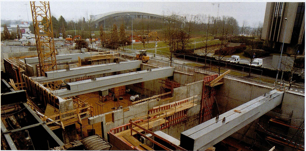
Les travaux de gros-oeuvre et charpente métallique ont atteint la dalle sur le niveau -1, qui est le premier niveau de parking
