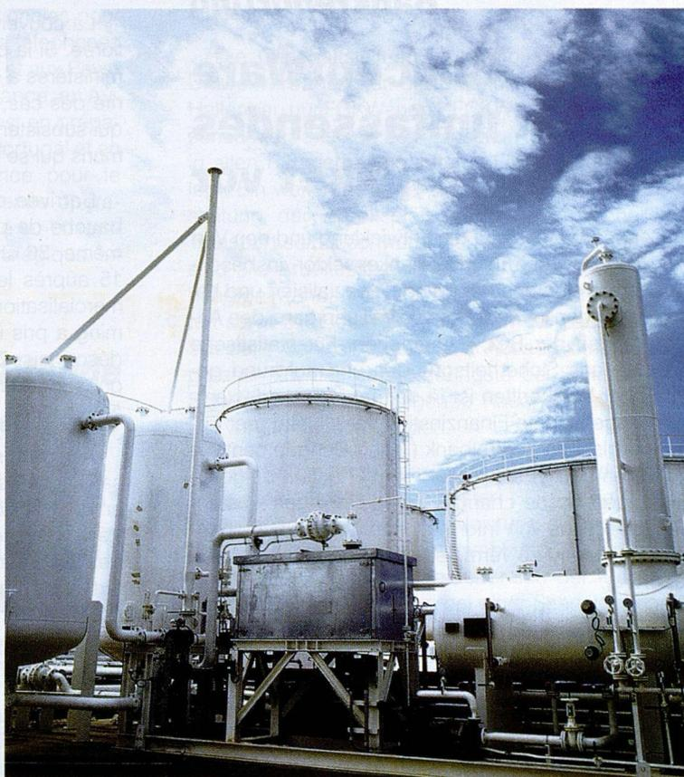
(vapor recovery unit) pour éviter l'évaporation de COV's lors du chargement, en opérant en circuit fermé. Pour des raisons de sécurité, tous les tuyaux et conduites sont désormais installés à bonne distance du sol au lieu d'être enterrés comme c'était le cas auparavant.
