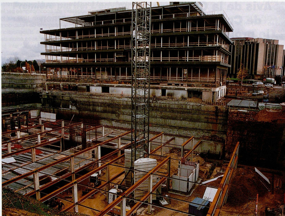
Chantier de la Chambre de Commerce au 10 novembre 2000.
