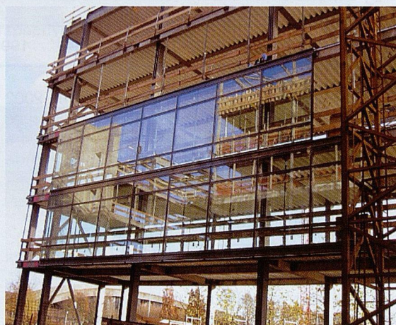
Premiers éléments de façade sur l'arrière du bâtiment C.
