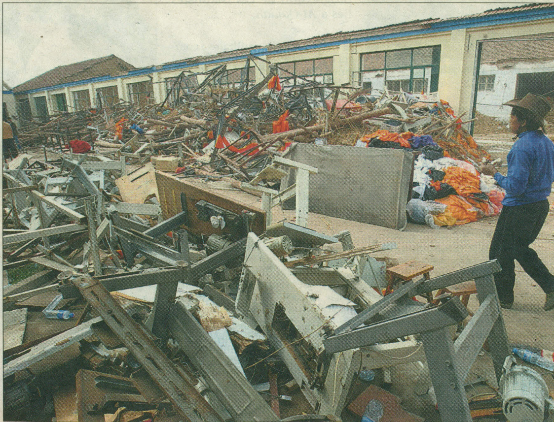
L'effondrement d'une manufacture de textile en Chine a fait vendredi dix morts: un événement courant dans ce pays, où les mesures de sécurité restent minimes
